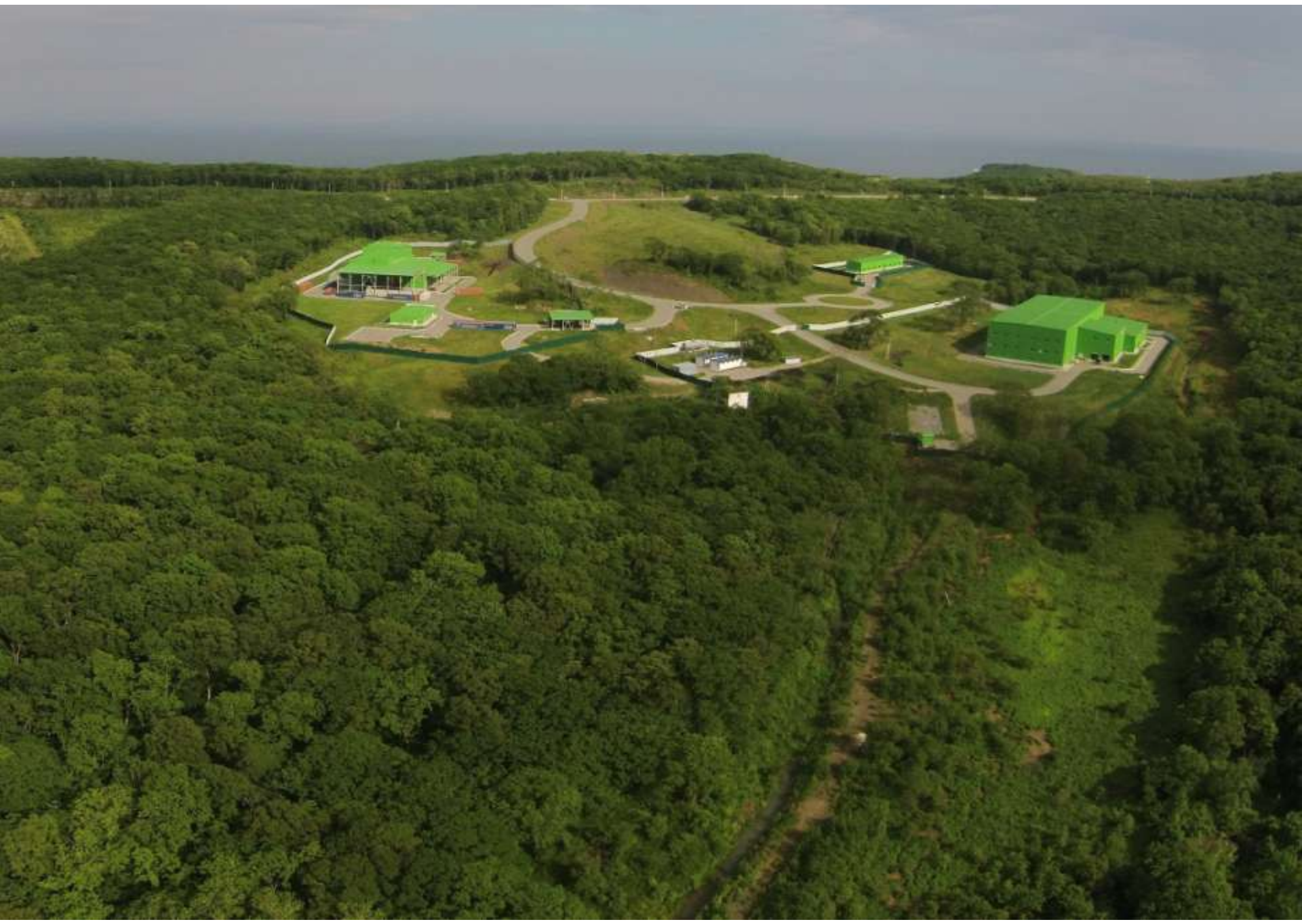
Общий вид очистных сооружений о. Русский (с северной стороны), июнь 2016 г.
