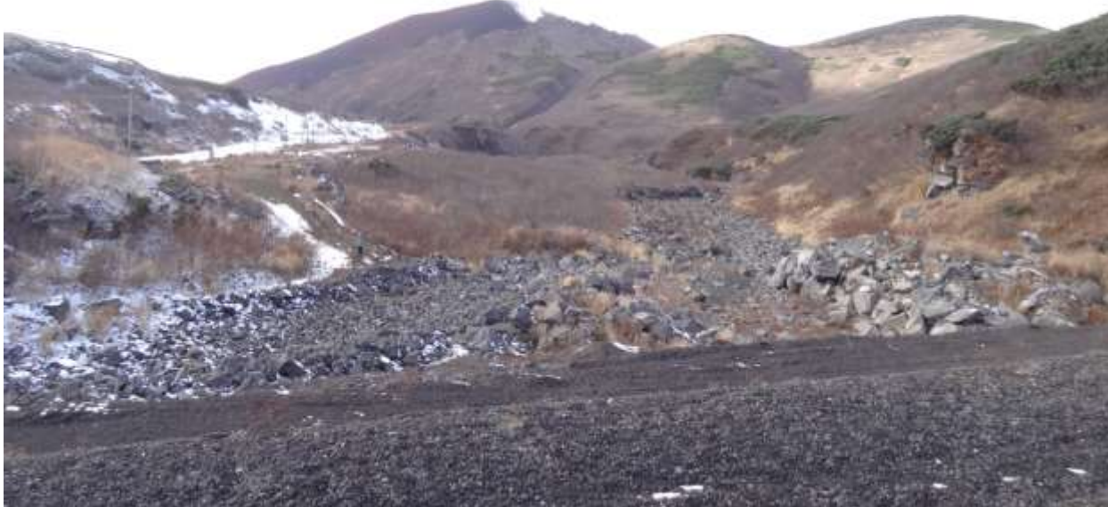
Рис. 8-9. На фото Толмачевская ГЭС-2 и сухое русло нижнего бьефа. Еще не вечер, воду накапливают в водохранилище до того часа, когда все включают электролампочки.
